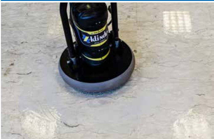
Micro-ponçage des pierres naturelles
