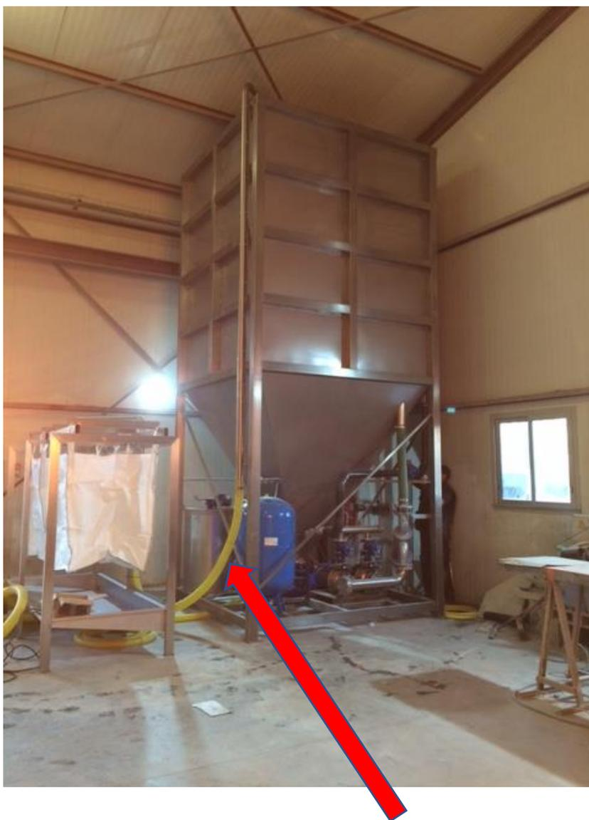
Les raccordements avec les tuyaux jaunes sont fournis par TURRINI qui permet de brancher la pompe immergée de la fosse inox au système et de la pompe de boue à l'ensachage dans les sacs ainsi que la récolte de l'égouttoir à l'évacuation dans la fosse inox.
