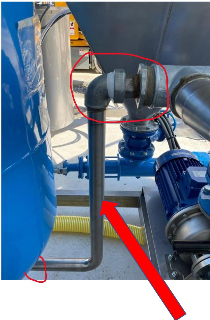
Le tuyau de raccordement du surpresseur aux pompes est fourni par TARRINI (attention il n'y a pas de vanne de fermeture si besoin, la modification et la vanne est à la charge du client par un plombier)
