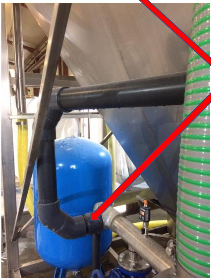
Le tuyau de sorti d'eau propre des pompes en 3" vers l'installation de l'atelier avec le BI PASSE, la fourniture et les raccordements sont à la charge du client par un plombier
